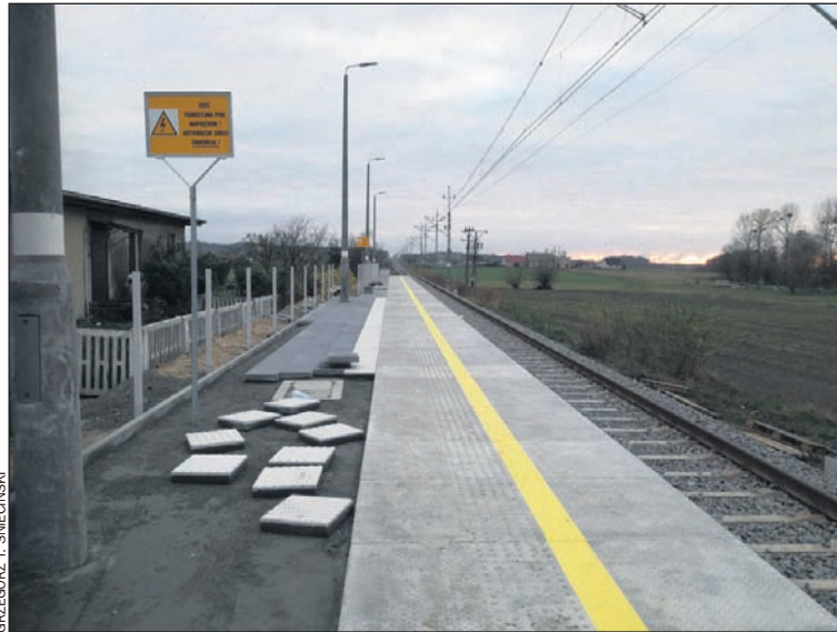
Na stacji w Cieszkowie trwają ostatnie prace
